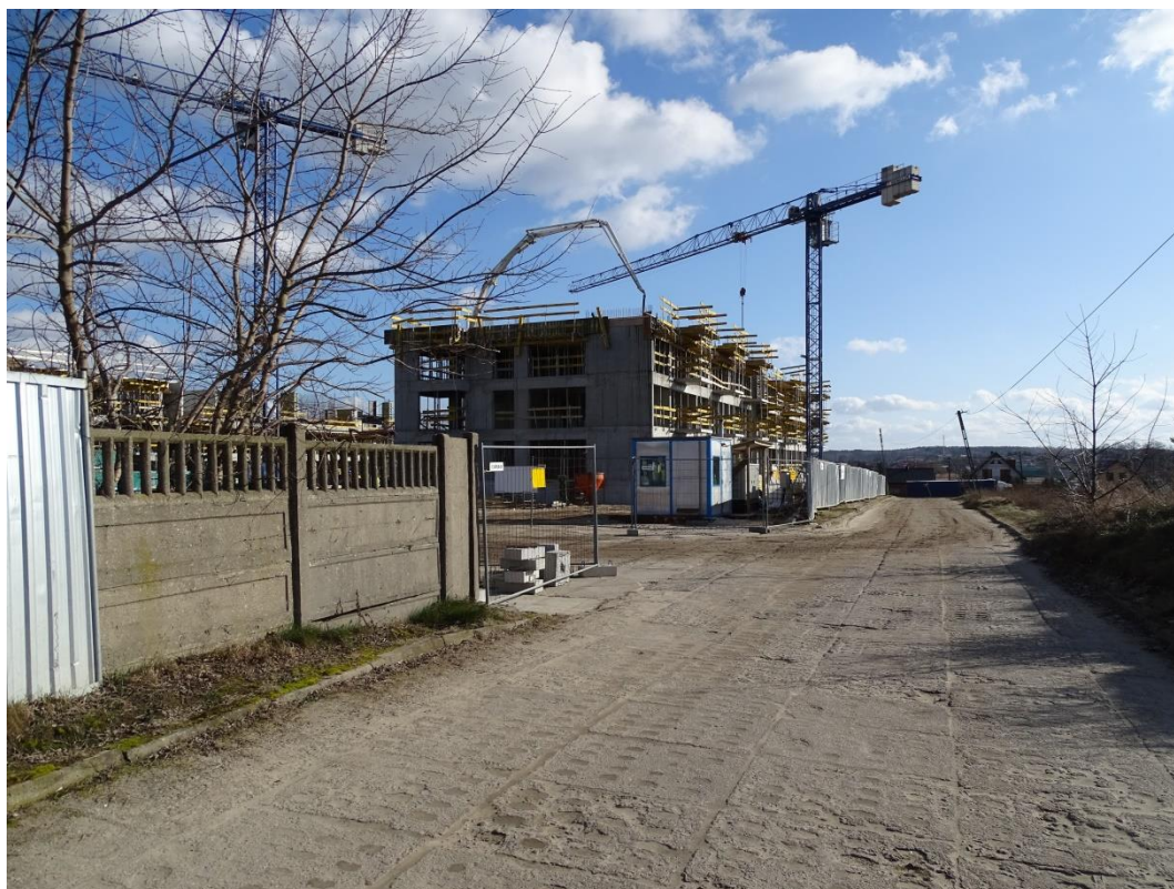
Zdjęcie Nr 8. Rawa Mazowiecka, rejon ul. Księżę Domki. Wgląd na zabudowę na terenie działki ewidencyjnej Nr 90/7 z drogi dojazdowej w kierunku południowo-wschodnim.
