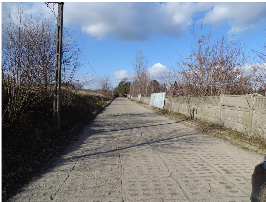
Zdjęcie Nr 7. Rawa Mazowiecka, rejon ul. Księżę Domki. Perspektywa drogi dojazdowej od strony południowo-wschodniej.
